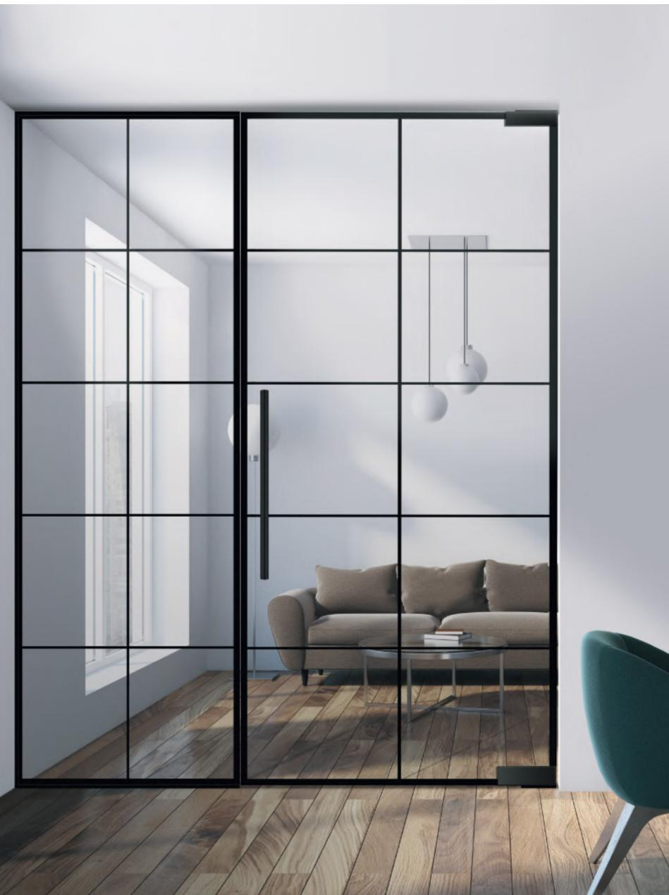
Pendeltüren lassen sich in beide Richtungen öffnen und regulieren sich sanft in die Schließposition.
